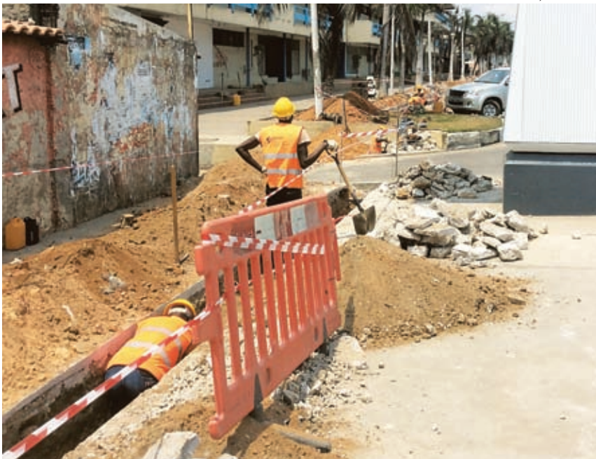
TRABALHOS Escavações decorrem para a instalação de cabos de energia
