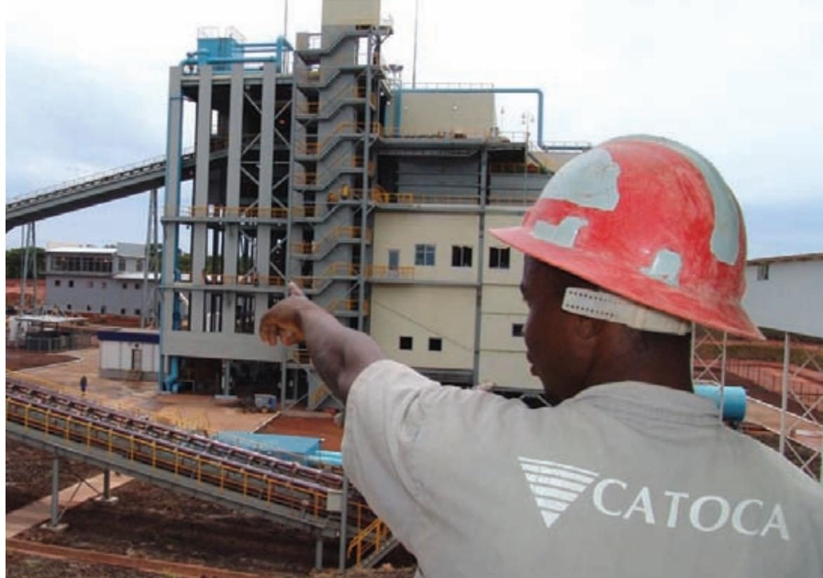
Edifício da central II de tratamento em destaque e parte do sistema de correias que transporta o cascalho levado da mina
