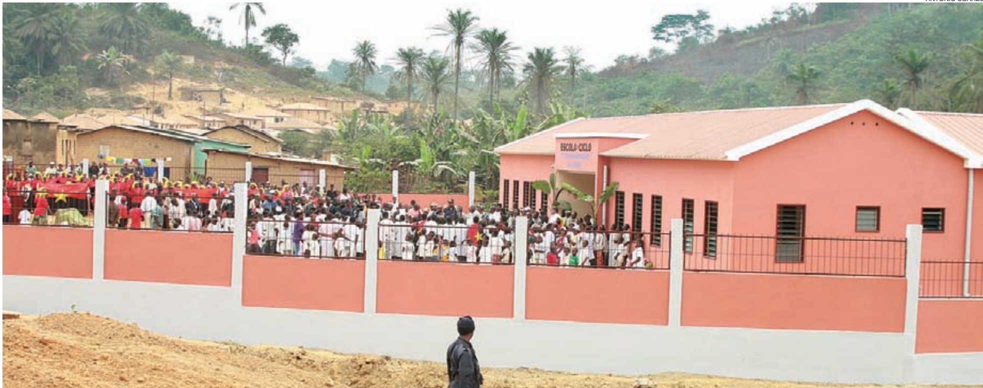
Centenas de crianças do município do Belize frequentam a nova escola construída no âmbito do Programa de Investimentos Públicos para dar às populações mais isoladas condições de vida dignas e com qualidade
