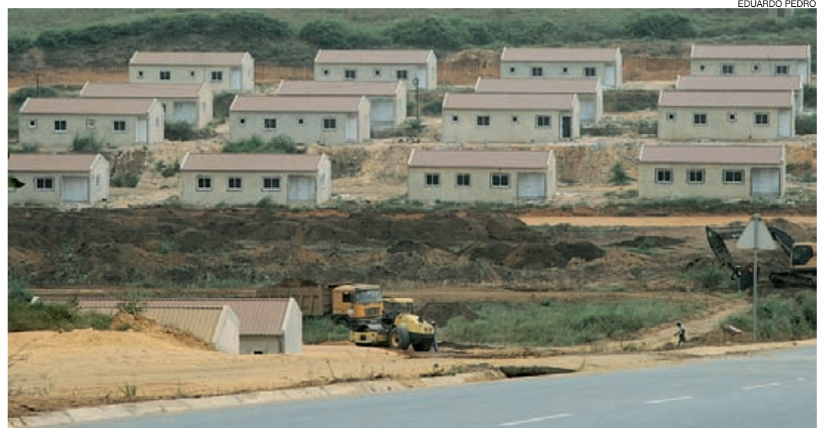
Bairro social com 200 habitações está em fase de acabamentos e nascem no município de Cacongo novos centros habitacionais
