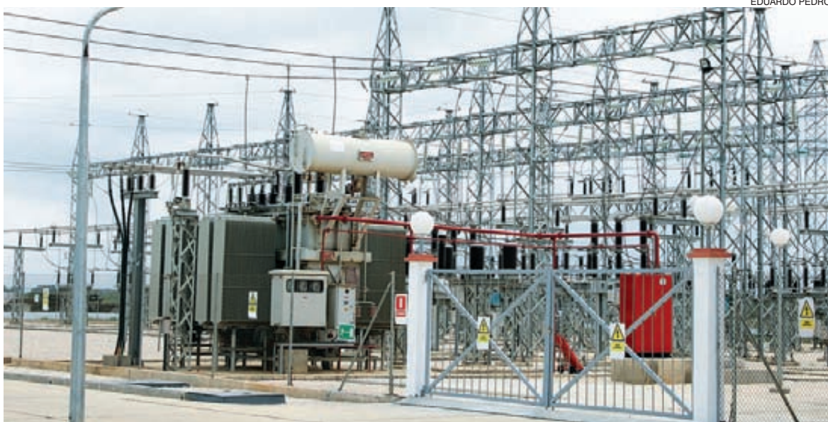
A central térmica de Cabinda está a responder às necessidades dos consumidores e resolveu o problema dos “apagões”
