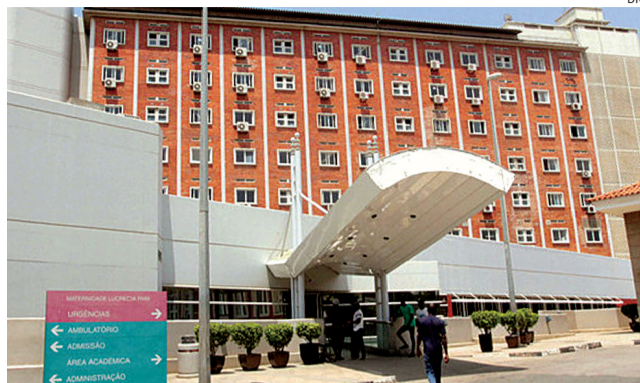
Parte frontal do edifício da Maternidade Lucrécia Paím
