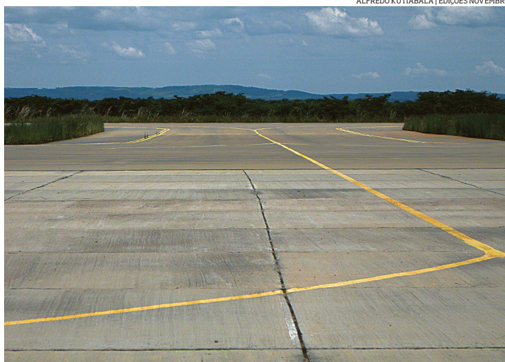
A pista de aterragem está dentro dos padrões internacionais da aviação
