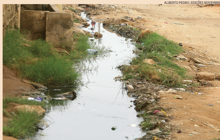
AR SANEAMENTO Águas paradas têm causado muitas doenças
